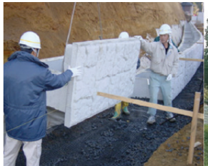
最下段箱体据付
