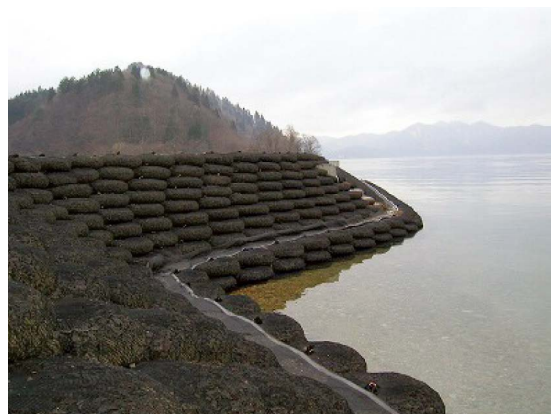
法面保護工・根固工
