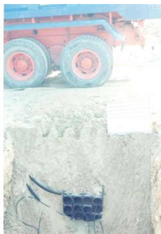
実車走行試験
