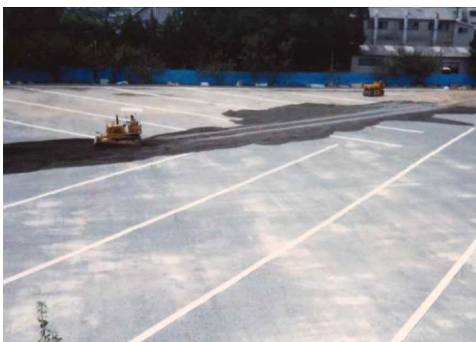
5)土砂まきだし状況
