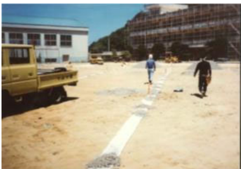
3)敷設時の仮固定（押え土）
