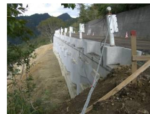
写真-2 施工完了 (災害復旧)
