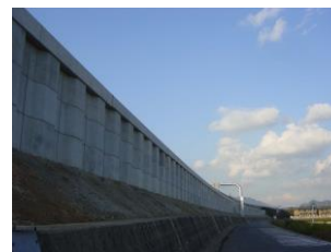
写真-1 施工完了 (高速道路拡幅)
