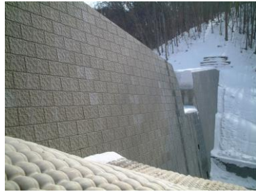
施工例：砂防堰堤
