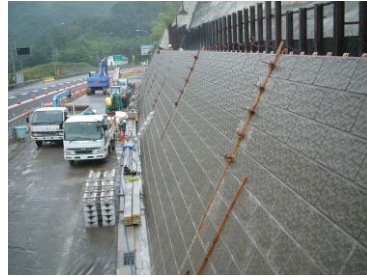
施工例：道路擁壁
