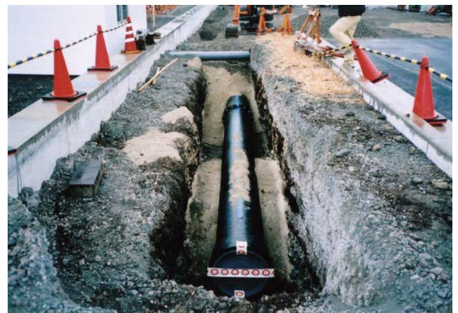
埋設管戻し使用
