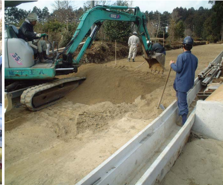
撒き出し・整地作業
