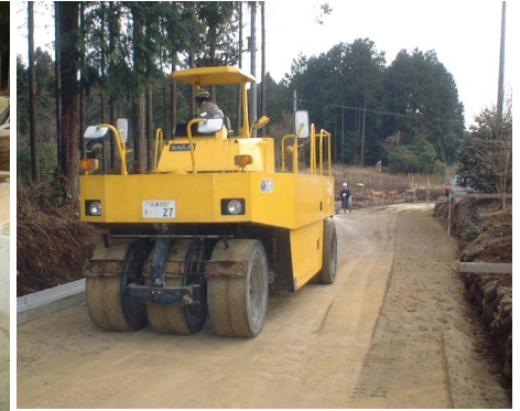
タイヤローラーでの転圧
