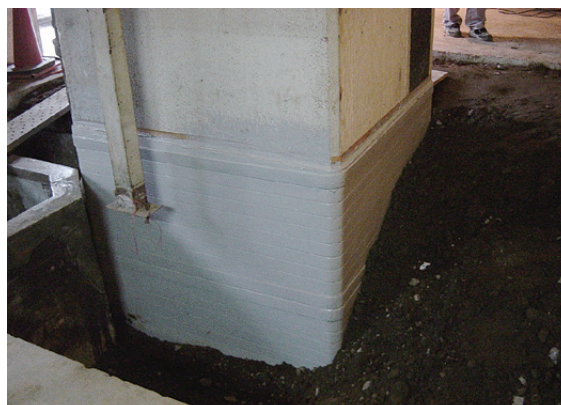
地中部分の補強(ウレタン樹脂塗布後、埋め戻し)
