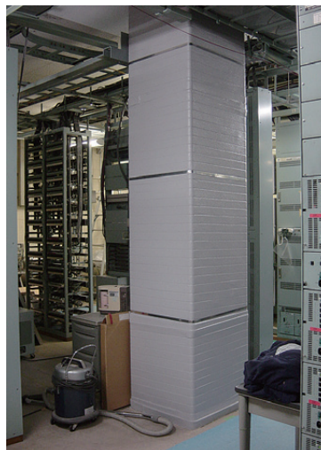
補強後被覆塗装実施
