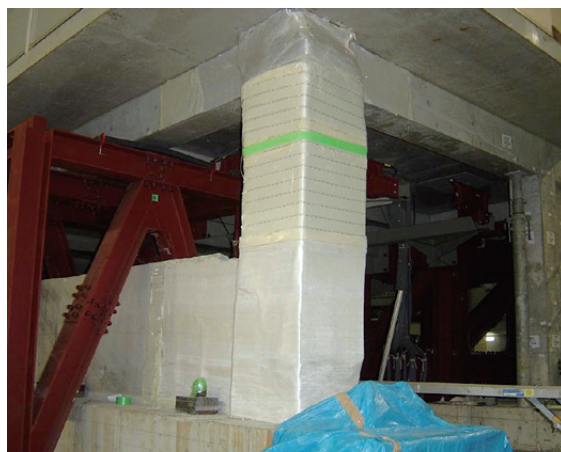
損傷柱の応急補強工事例
