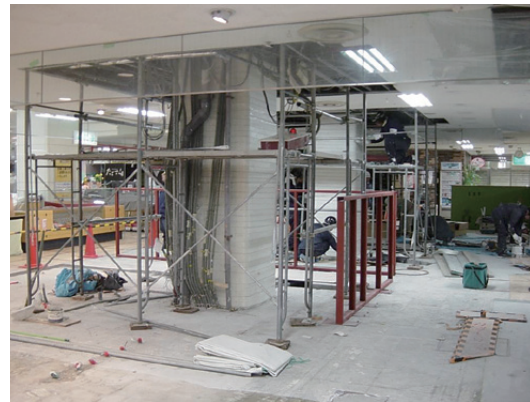
補強材貼り付け状況 (配管を生かしたままの施工)
