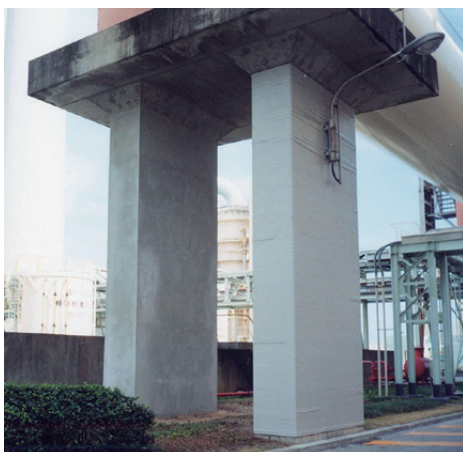
モルタル仕上げ(左柱は施工完了、右柱は施工前)
