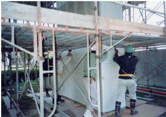
補強材貼り付け状況
