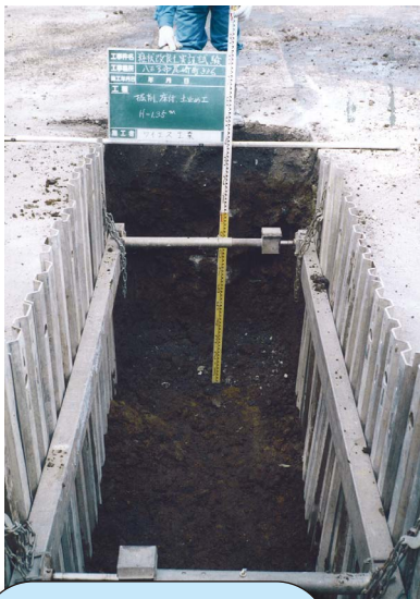
掘削・土留め
