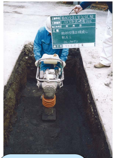
ランマー転圧
