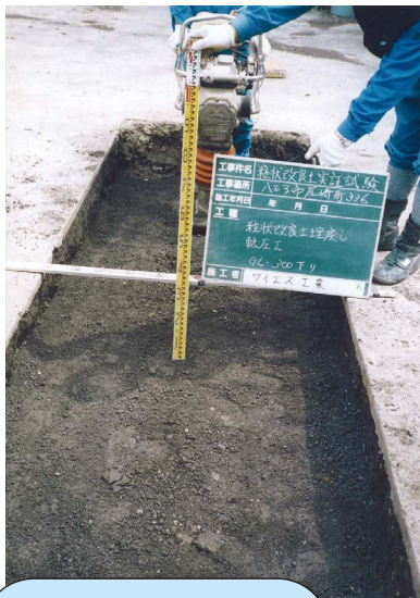
埋戻し最上部（路床）
