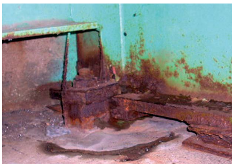
支承交換前 (線支承)
