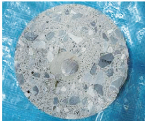
グラウト材の充填状況
