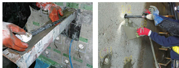
高流動グラウトによる施工 可塑性グラウトによる施工
