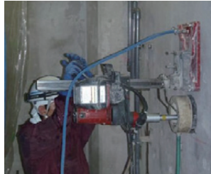
コアドリルによる削孔
