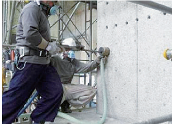
レッグハンマーによる削孔
