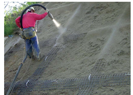
③ 改良土吹付工
