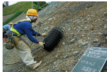
施工性の向上 (軽量・コンパクトなジオグリッドの設置)
