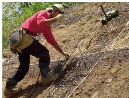
② L型アンカー工
