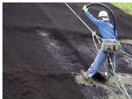
⑤ 植生基材吹付工
