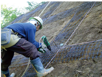
① ジオグリッド設置工
