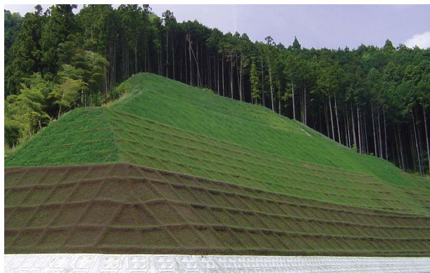
全面緑化により、のり面緑化面積を増大できる。
