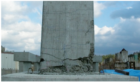
半円形フックを用いた試験体の試験後状況
