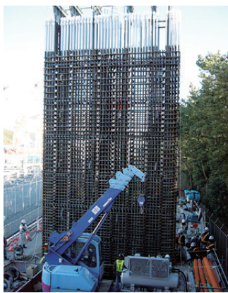
鉄筋組立てユニットの揚重状況
