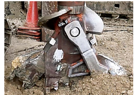
〔根固め部掘削・築造時〕
