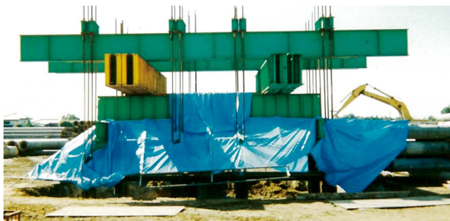
杭の押し込み載荷試験
