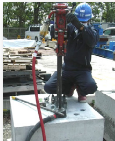
図-4 コアボーリング削孔型、先注入法（横向き）の施工手順
