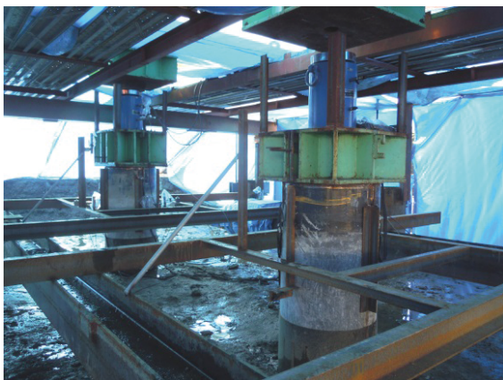
写真1 鉛直軸荷試験状況
