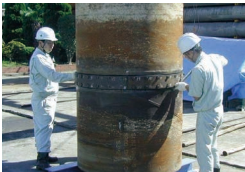
写真2 施工試験状況
