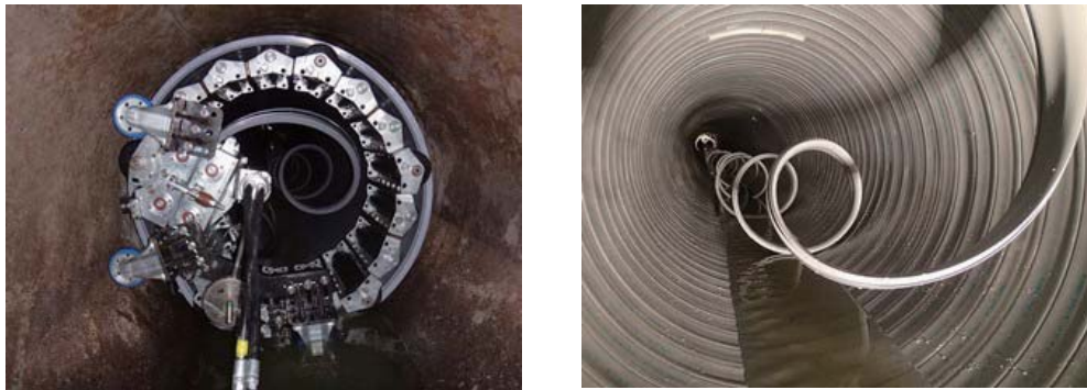
写真-1 製管状況（自走式製管方式）
