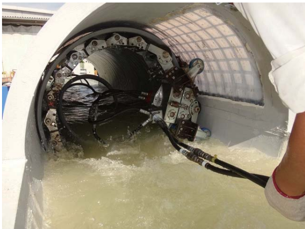
写真－3 施工性試験 (供用下での製管)
