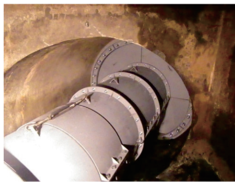
写真-1 SCプラグ・バイパス管設置完了
