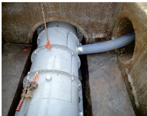
写真-1 SCプラグ・バイパス管設置完了
