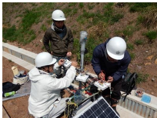
図-1.2 モニタリングシステム構築の様子
