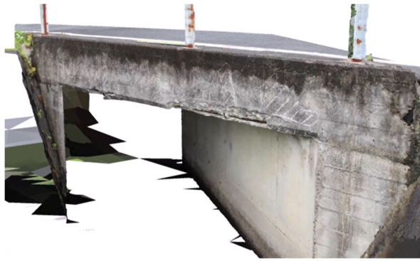
(a) RC 床版橋
