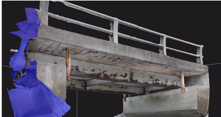
(b) 鋼プレートガーダー橋
