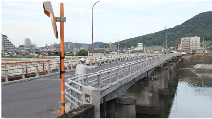
図-6 撮影棒を用いた高欄の外側の撮影
