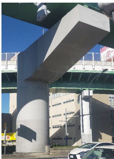
図 3.14 提案手法では梁のモデル化が容易でない鋼製橋脚の例
