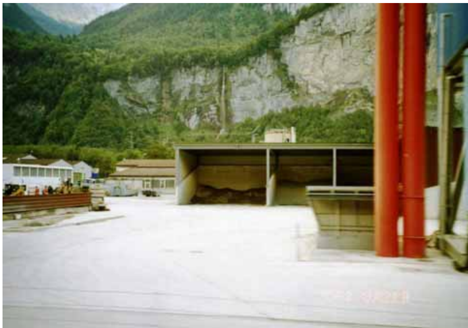
【写真 5.1.4】 GHELMA 社外観（車窓より）
