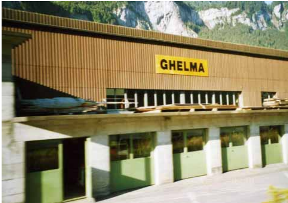
【写真 5.1.3】 GHELMA 社外観（車窓より）
