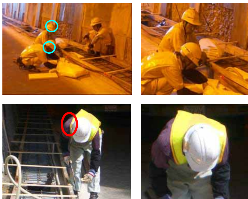
写真 3-4 RFID TAG を装着し、作業を行う様子
