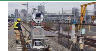
【品川駅切換工事】3D測量による完成検査を試行
