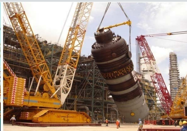
Actual Rigging Work
