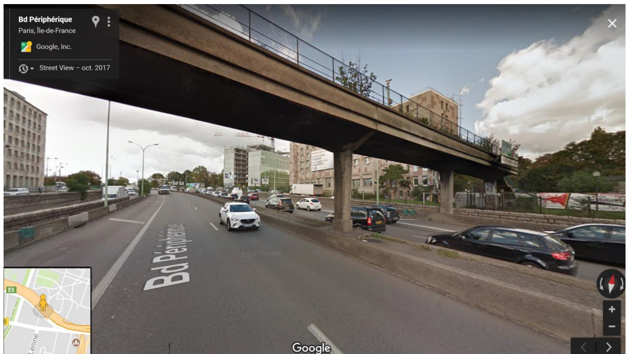
写真 7：プロジェクトの敷地の一部として設定されたパリ環状高速道路の現状写真
