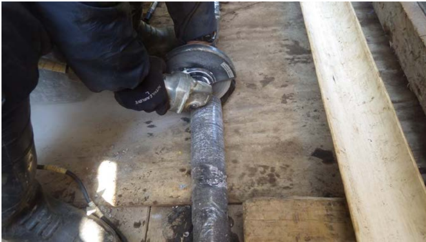
写真 10-2 ボーリングコアの切断状況
