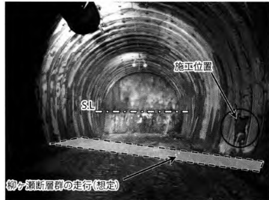
図 2.4.2 コアボーリングの施工位置
