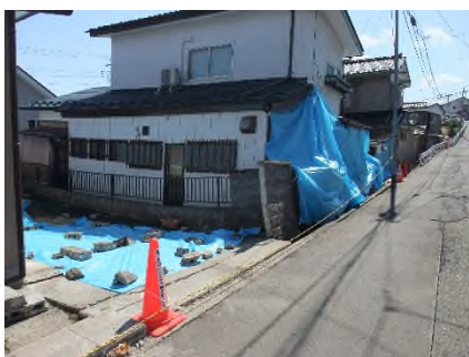
写真 2.9.1 ひな壇状のすべりで被災した住宅
