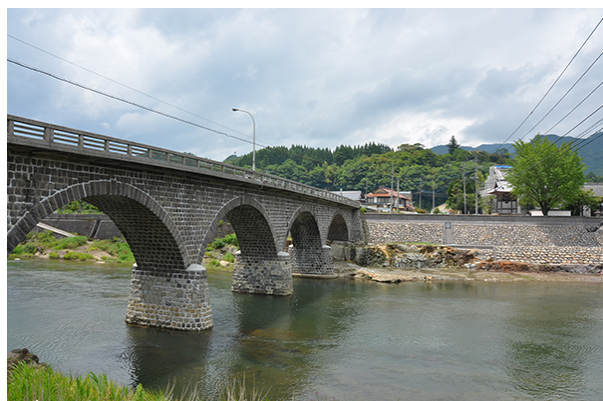
図 5-5-11 下流左岸西浄寺の石積と馬溪橋
