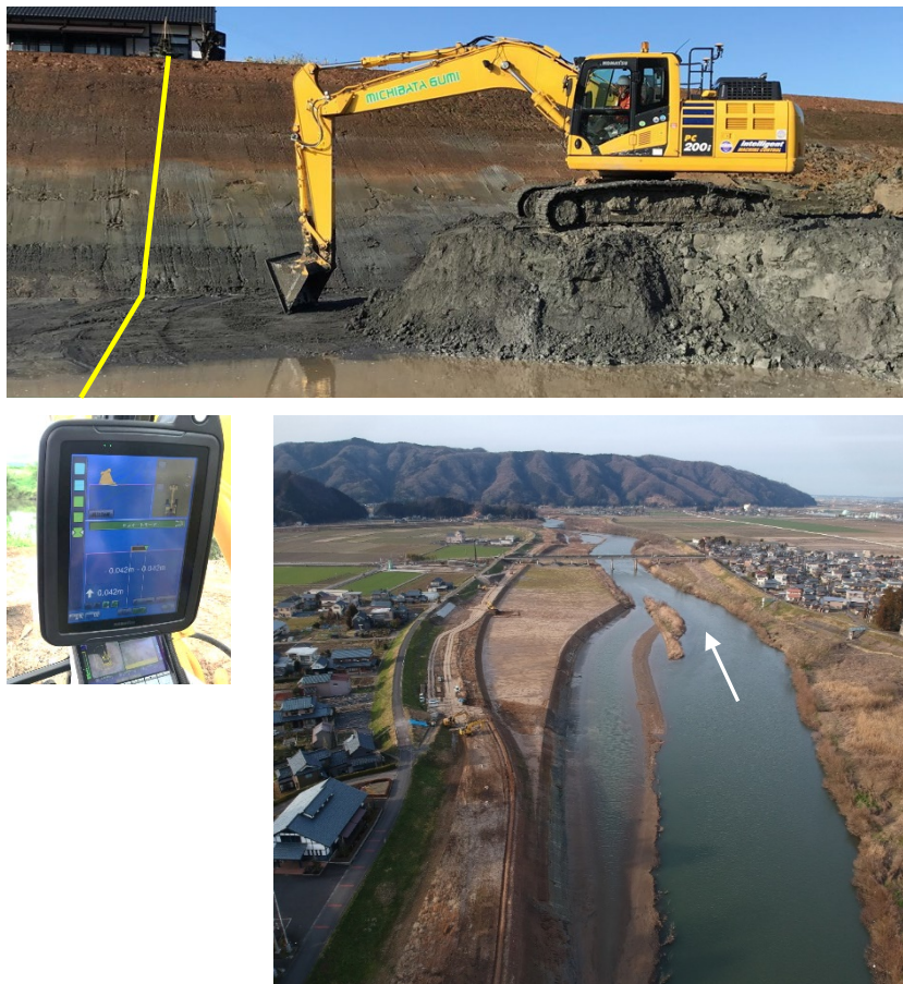
図 4-3-12 ICT 施工状況と完成写真
