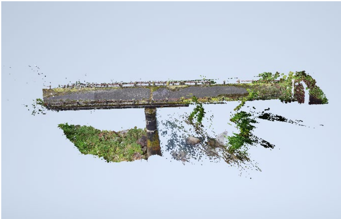
図-32 旧落合橋の点群データ
