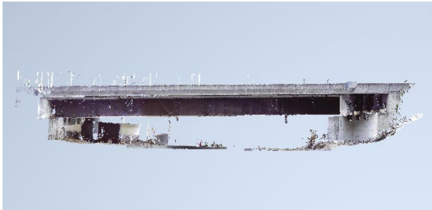
図-28 新前川橋の点群データ
