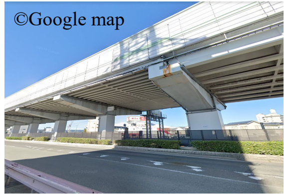
高架橋下の現場写真
