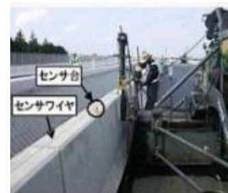
従来技術による施工状況
