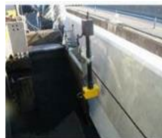
カメラアイによる施工状況
