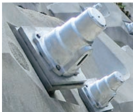
目視管理型ヘッドキャップ 設置状況
