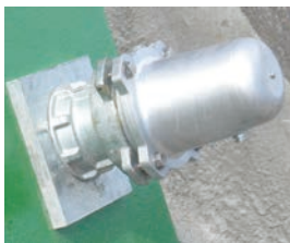
窓付止水具設置状況
