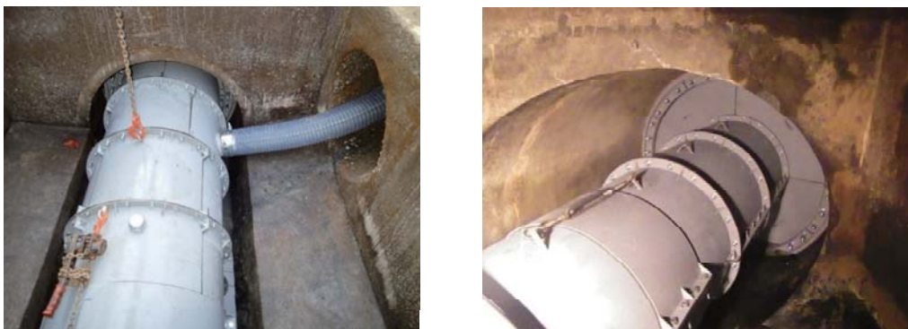
写真-2 SCプラグ・バイパス管設置完了
