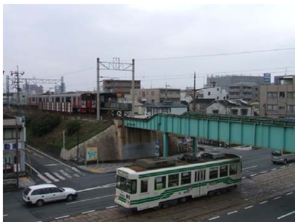
写真-4 現場周辺
