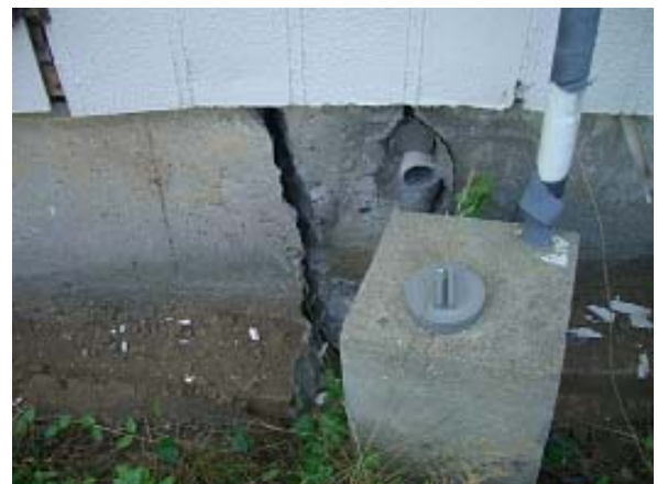
写真 4.2.2 戸建て住宅の基礎被害例
