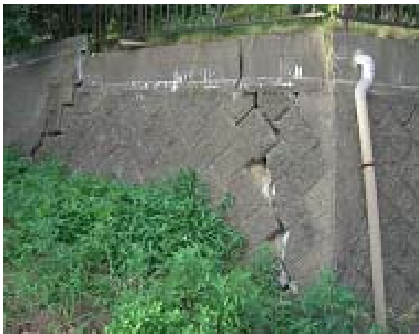
写真 4.2.3 山本地区における擁壁の被害事例
