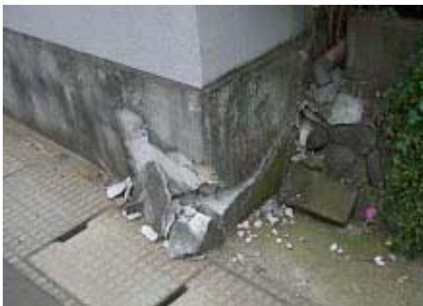
写真 4.2.2 戸建て住宅の基礎被害例
