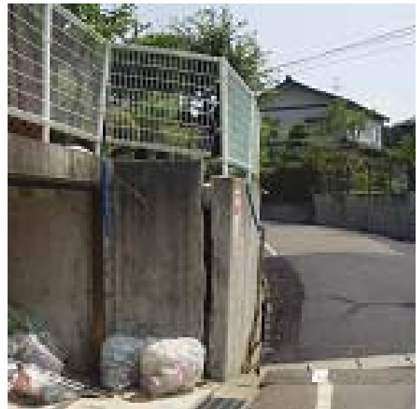
写真 4.2.3 山本地区における擁壁の被害事例
