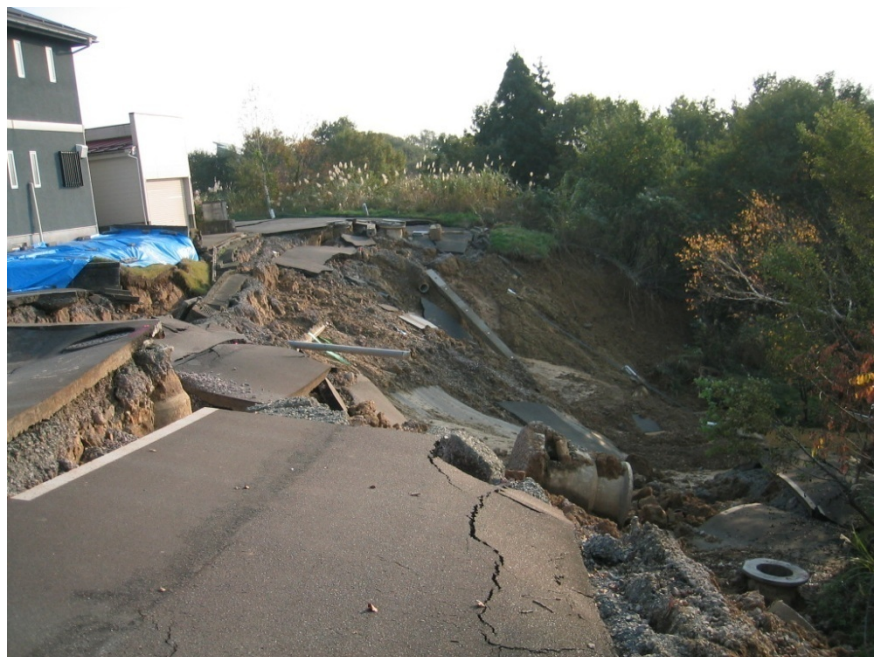
写真 2.2.5 盛土の崩壊 ((株) 興和提供)
