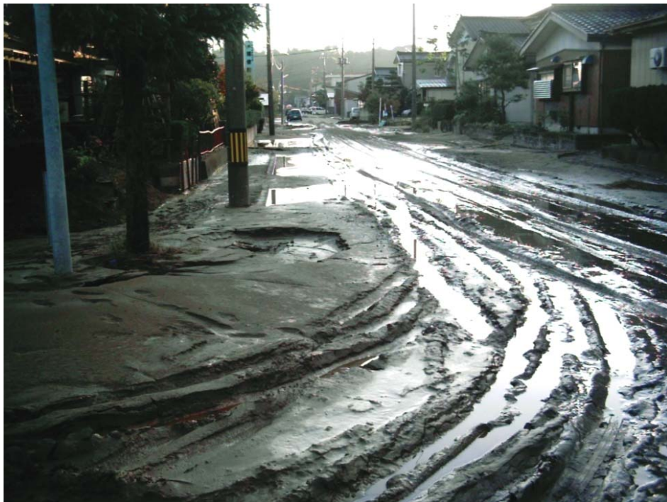
図 3.1.1 見付市内の液状化発生の様子（(株)興和提供）
