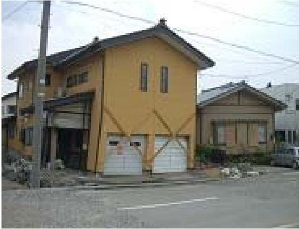
写真 4.2.1 松波地区の液状化被害
