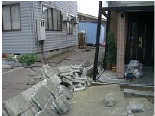
写真 4.2.1 松波地区の液状化被害
