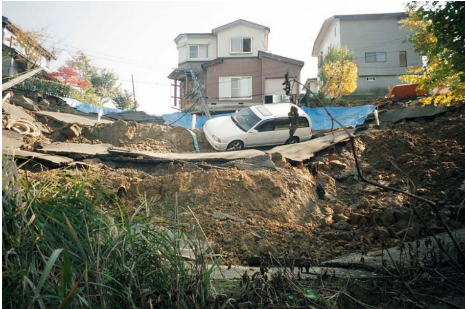
写真 2.2.6 盛土の崩壊（(株) 興和提供）
