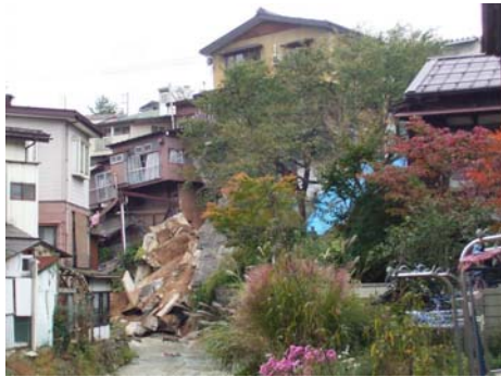
a 小千谷市 斜面の宅地崩壊
