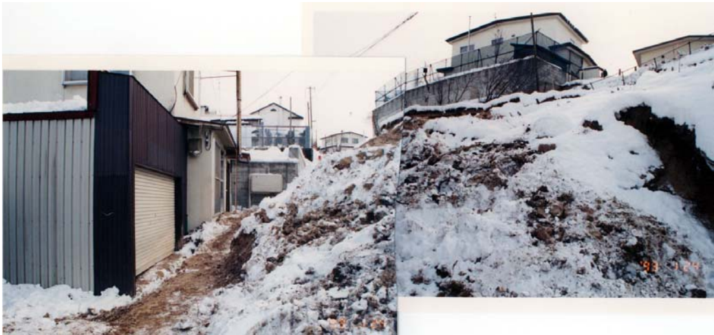
b 釧路市材木町 盛土の崩壊
