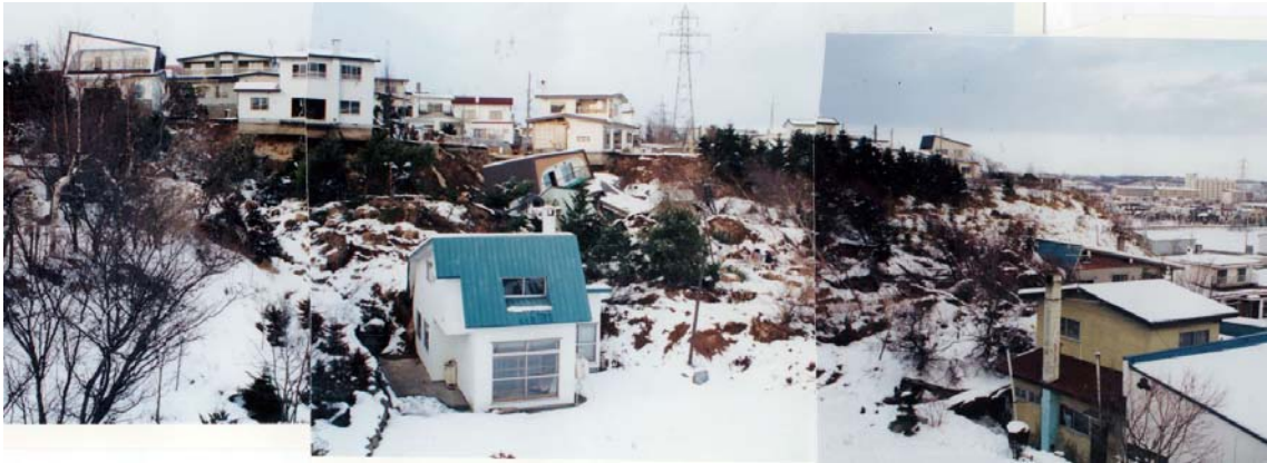
a 釧路市緑ヶ岡 盛土の崩壊
