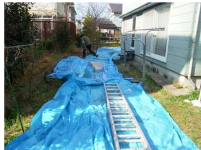
e 長岡ニュータウン(青葉台) 切盛境界部か, 宅地に段差のある亀裂
