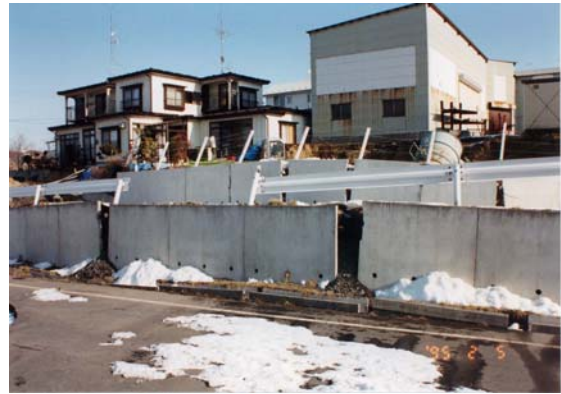
a 松ヶ丘の谷埋め盛土末端部の崩壊
