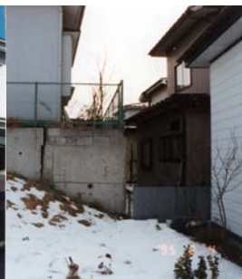
a 松ヶ丘の谷埋め盛土末端部の崩壊
