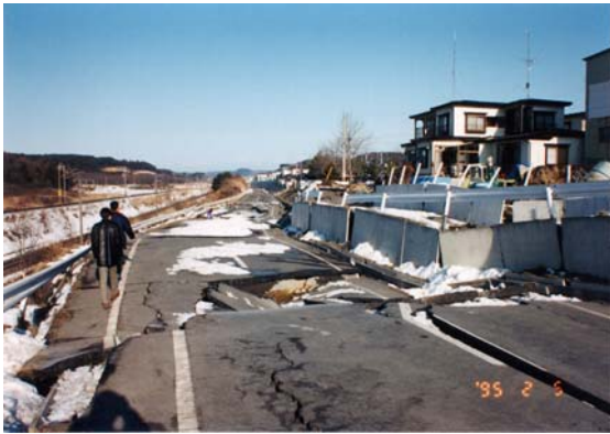
a 松ヶ丘の谷埋め盛土末端部の崩壊
