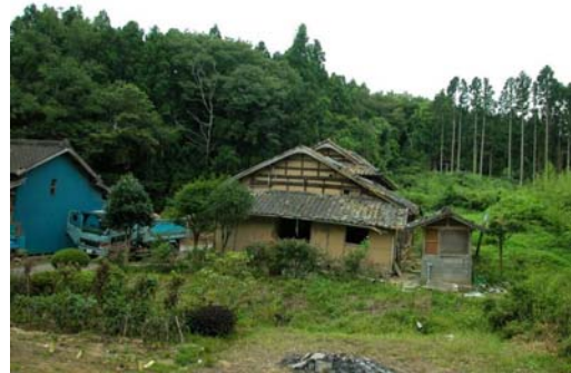
b 北村地区 右手前側盛土部の沈下
