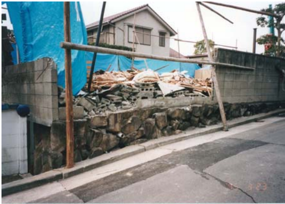
a(上) 神戸市垂水区 A 団地 切盛境界部, 左側が盛土部 不同沈下で家屋取壊し済み, 埋設管の修理跡
