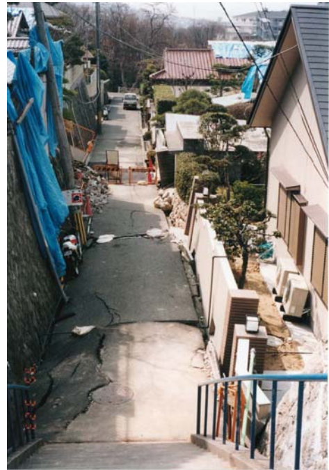
a(上) 神戸市垂水区 A 団地 切盛境界部, 左側が盛土部 不同沈下で家屋取壊し済み, 埋設管の修理跡
