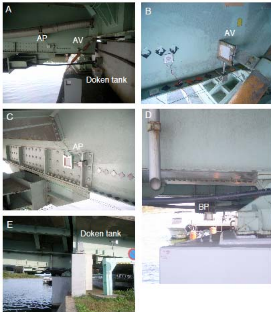
図 3-5 対象とした鋼橋梁における飛来塩分量測定の様子. 各橋梁に設置された土研式タンクとドライガーゼ捕集器の位置を示した. 飛来塩分捕集用のガーゼは, 捕集面と橋梁の桁が直行するもの (BP), ガーゼの捕集面がウェブ面と平行になるもの (AV) と垂直になるもの (AP) の計 3 点を設置した. (武邊ら, 2008 より引用)
