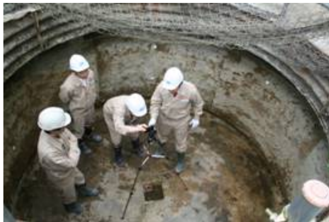
写真-4.2 模擬立坑壁面形状測量実験状況
