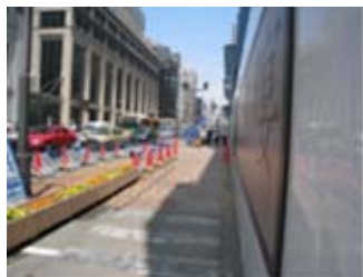
写真-4.20 地下道拡幅工事入口
