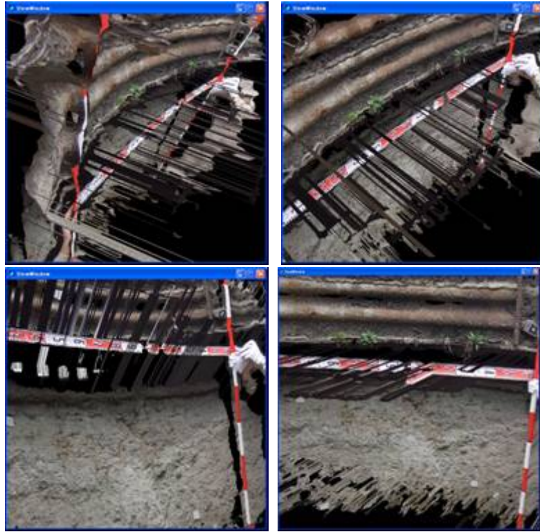
写真-4.3 撮影された壁面形状の3次元化写真の例(視角を変化させた同一画像)
