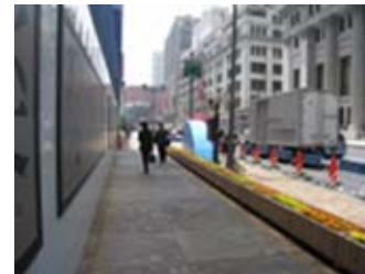
写真-4.21 既設地下道から拡幅工事部を見る
