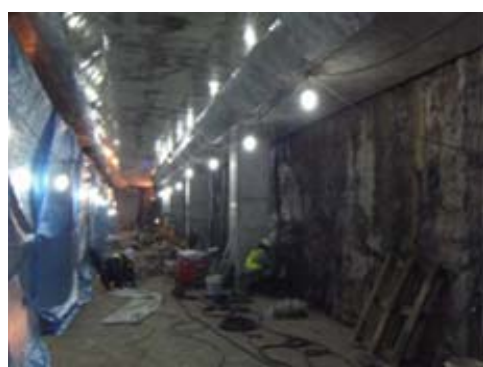
(a)形状測量実験区間の状況
