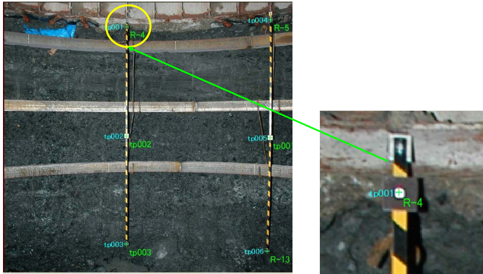
図-3.6 壁面形状測定時の座標ターゲット設置状況
