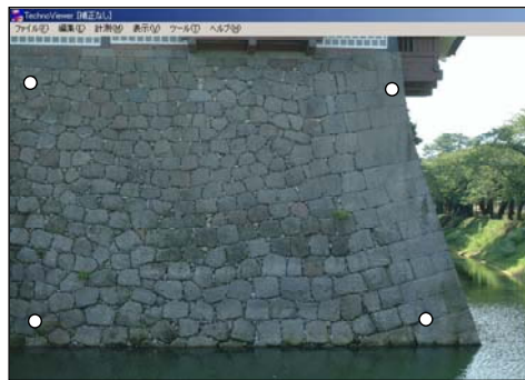
写真-4.11 偏位修正を行うための基準点の設定
