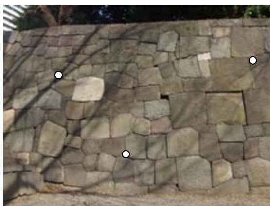
写真-4.13 石垣面への基準点の設置
