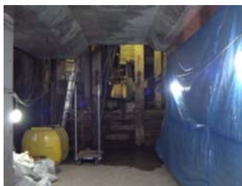
(b)工区境付近の現場状況
