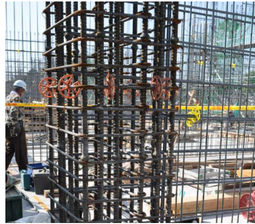
写真. 2. 3. 2 柱鉄筋の詳細
