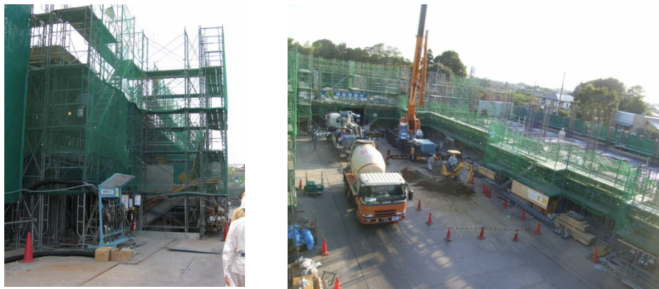
写真. 2.1.1 実験当日の建築現場の様子
