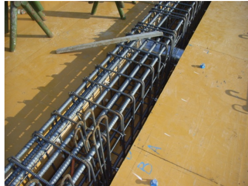
写真. 2. 3. 6 梁鉄筋の写真
