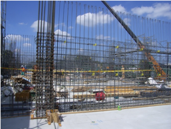
写真. 2. 3. 1 柱と壁鉄筋の出来形の状況
