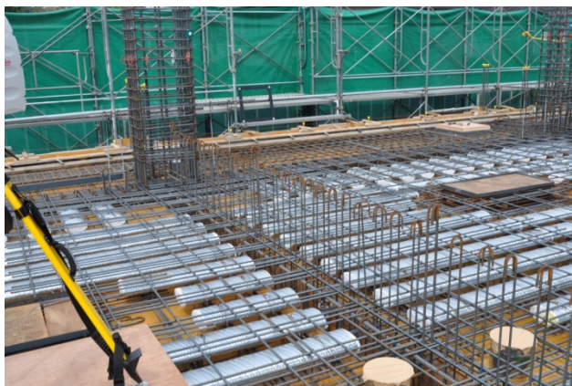
写真.2.3.7 床鉄筋の状況
