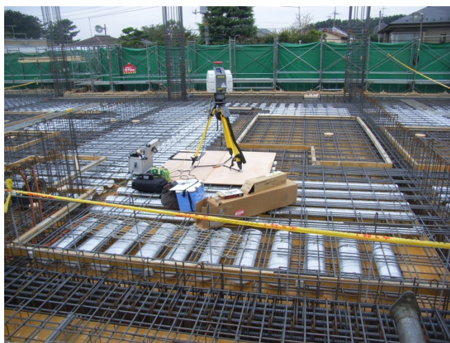
写真.2.3.8 スラブ筋計測時の状況
