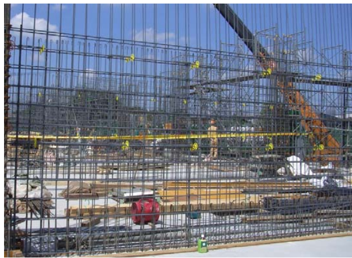
写真. 2. 3. 3 壁鉄筋の詳細
