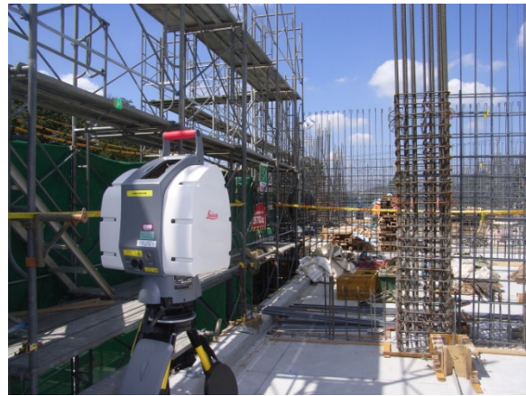
写真. 2. 3. 4 3次元スキャナー設置の様子
