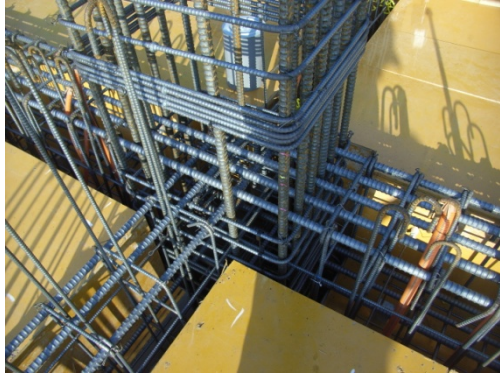
写真. 2. 3. 5 柱・梁鉄筋の写真
