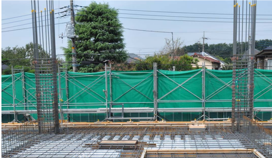
写真. 2. 3. 9 柱鉄筋に取り付けたターゲット
