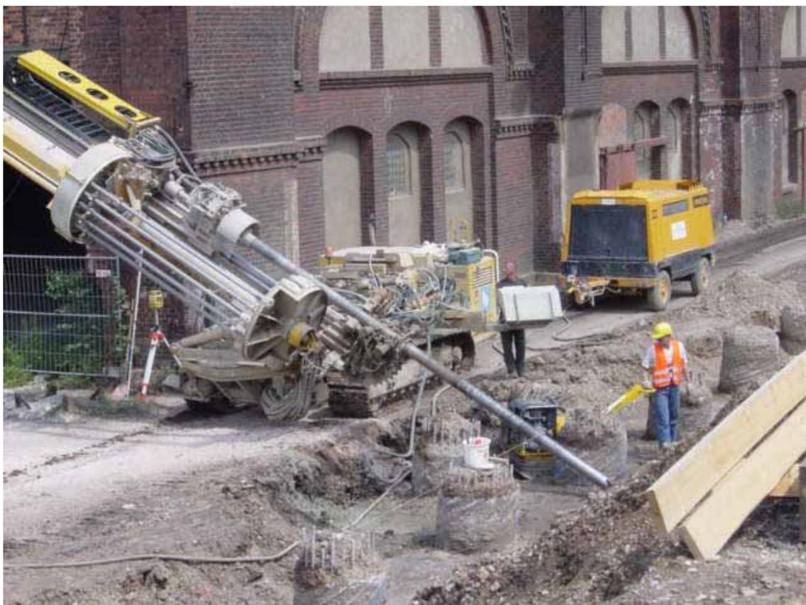
写真5-8. 山留め掘削作業
