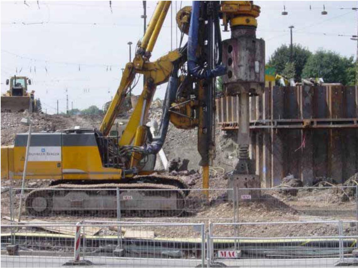
写真5-3. 杭打ちにおける掘削作業
