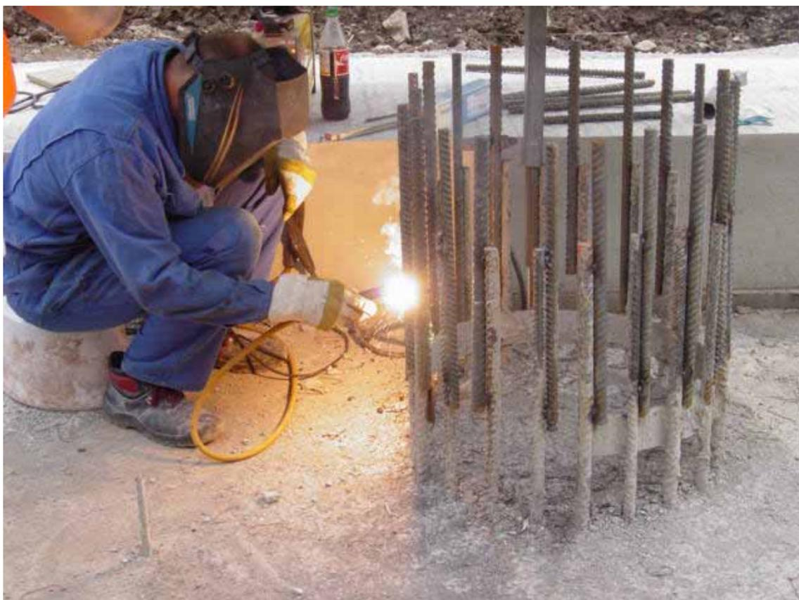
写真5-6. 杭基礎鉄筋溶接作業
