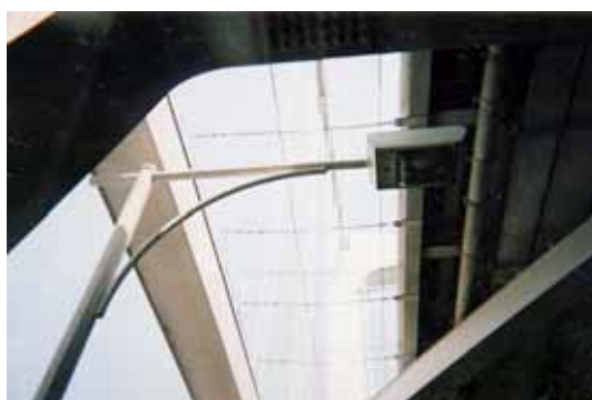
図 6.7 遊歩道照明柱
