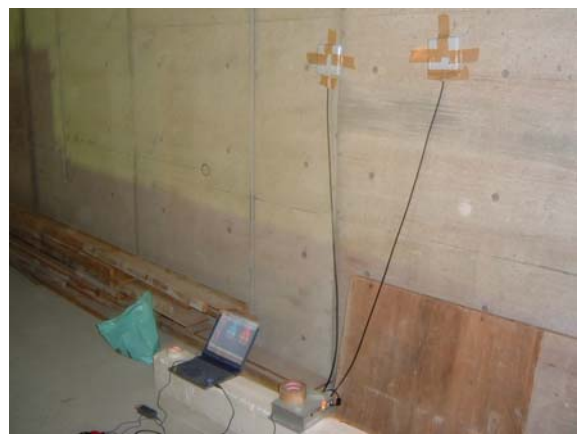
写真 3-6 Active Type system の設置状況 2
