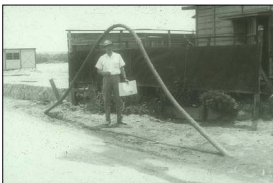
図 2.10 地盤の圧縮ひずみによる天然ガスパイプラインの座屈 (1964 年新潟地震,新潟市)
