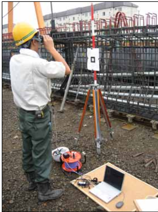
図 - 2 7 配筋チェック AR システムの現場実験
