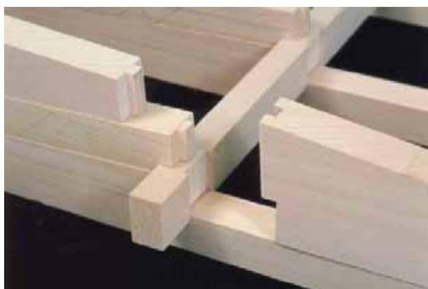
写真4 桁組み継手部
