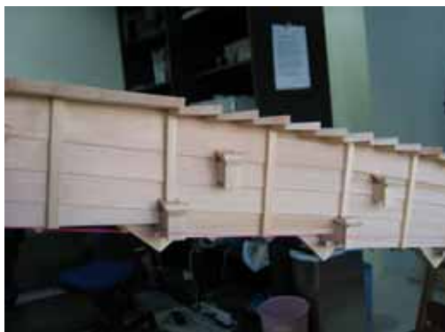
写真 17 橋板の取り付け
