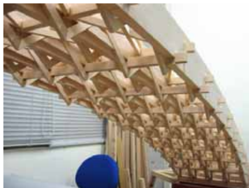
写真 15 鞍木・助け木の取り付け
