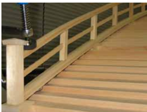
写真 18 高欄の取り付け
