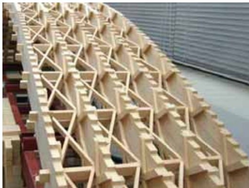
写真 16 振れ止めの取り付け
