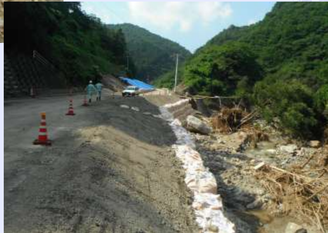
応急対策後(7日後)
