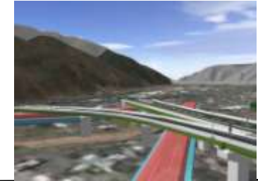
八王子南バイパス 調整池 (中央復建コンサルタンツ(株))
