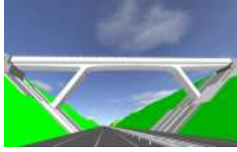
能越自動車道(七尾氷見道路) PC方杖ラーメン橋 (パシフィックコンサルタンツ(株))
