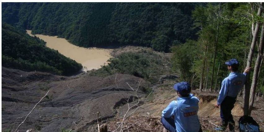
河道閉塞箇所の現地調査
