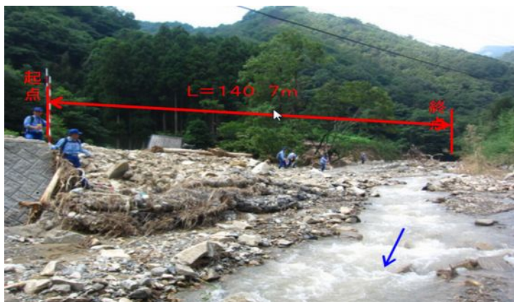
被災状況調査(河川班)
