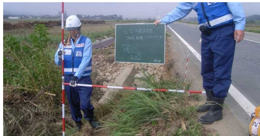
被災状況調査(道路班)
