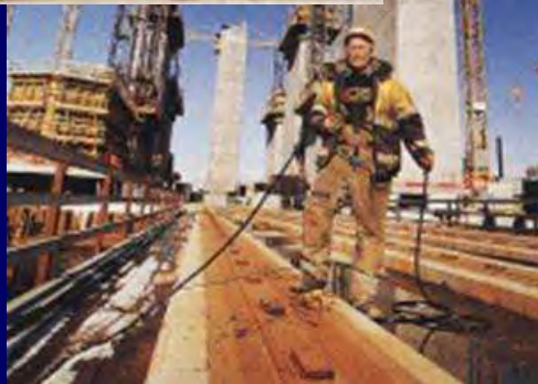
ピアーの海上 引出し作業
