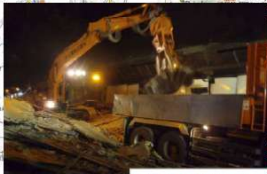
崩落板撤去状況
